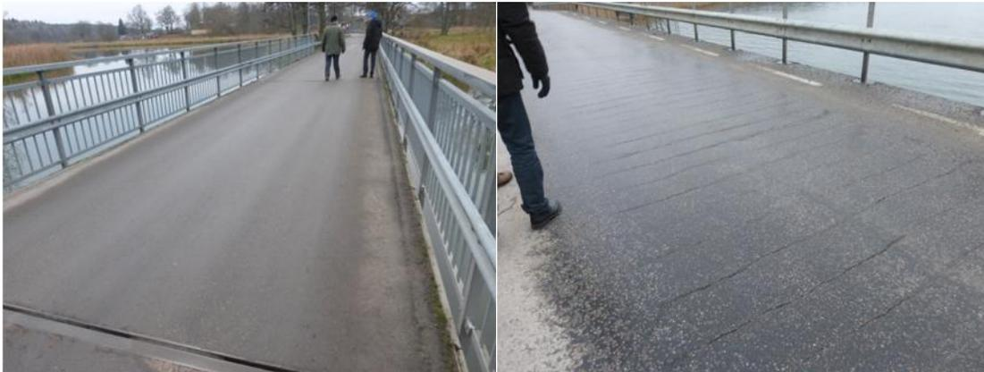
**Figure 2** – Un exemple de pont visité et un exemple de fissuration du platelage
