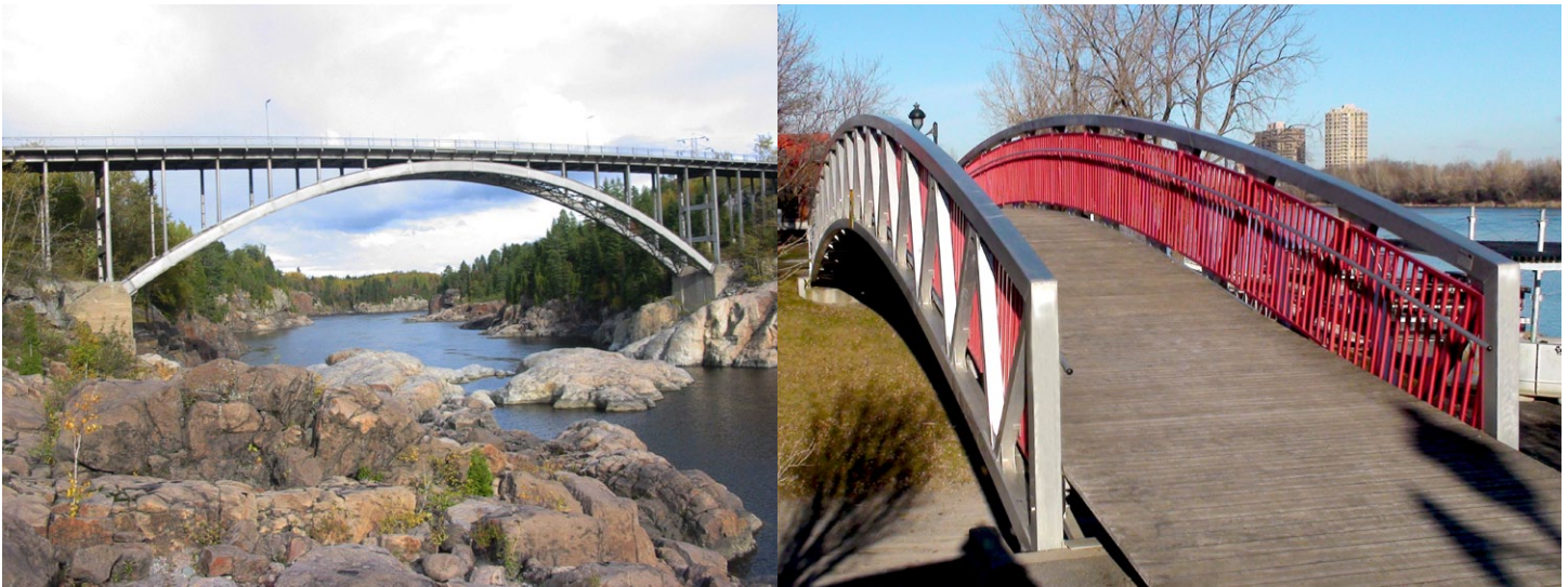
Figure 1. Pont d'Arvida au Saguenay, Québec (gauche) , installation d'une passerelle piétonnière à Montréal (droite).
