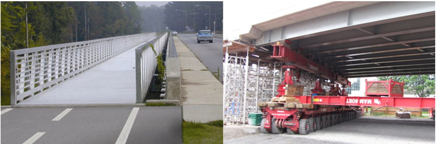
Figure 4. Piste cyclable en porte-à-faux (gauche) [C8], remplacement de pont accéléré en Ontario (droite).
